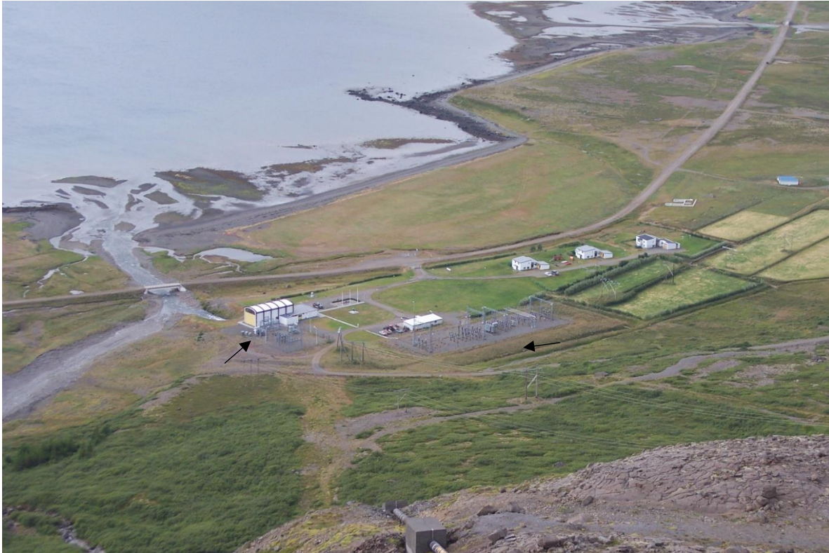
Mynd 3-5 Séð frá fjallsbrún við Mjólkurárfossa niður í Borgarfjörð. Stöðvarhús Mjólkár I og II er til vinstri. Á myndinni sjást tengivirki og örvarnar sýna fyrirhugaða staðsetningu þeirra.
