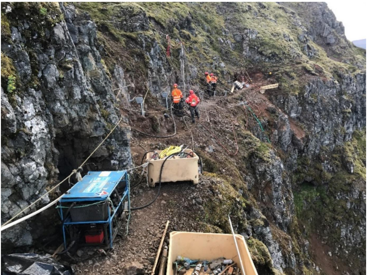
Unnið að borun.
