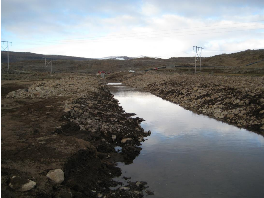
Mynd 8-4 Dæmi um veituskurð við Prestagilsvatn á brúninni ofan við Borgarfjörð. Fyrirhugaðir skurðir verða að jafnaði dýpri og með brattari hliðum í klöpp.
