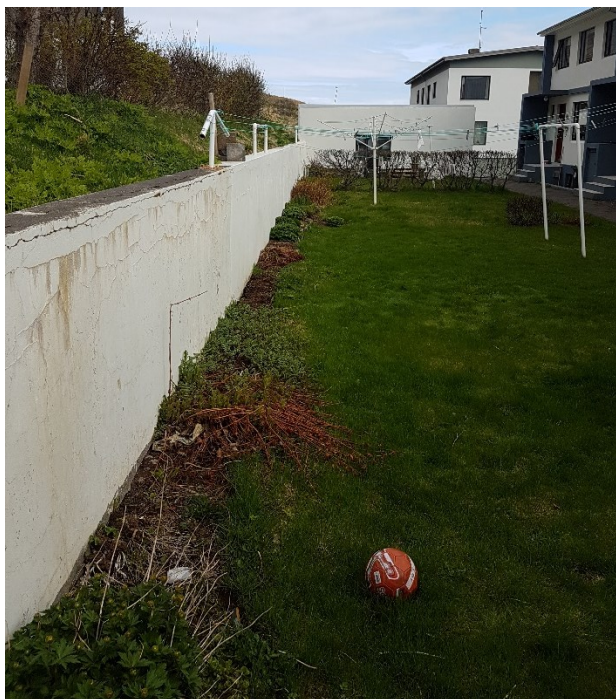
MYND 6: Stoðveggur á milli baklóðar og lóða við neðanverðan Hjallaveg, tekið í austur, bílskúrar Hlíðarvegs 41 og 43 við endann.
