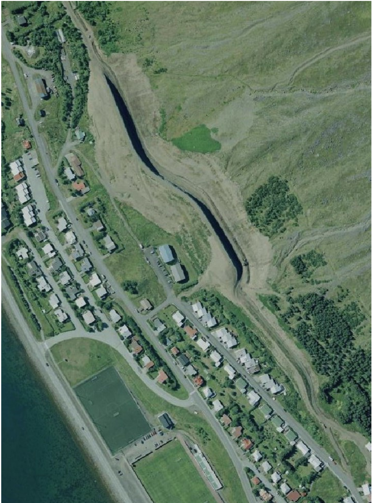
MYND V6: Svæði varnargarða ofan Urðarvegs og Seljalandsvegar eftir að framkvæmdum lauk
