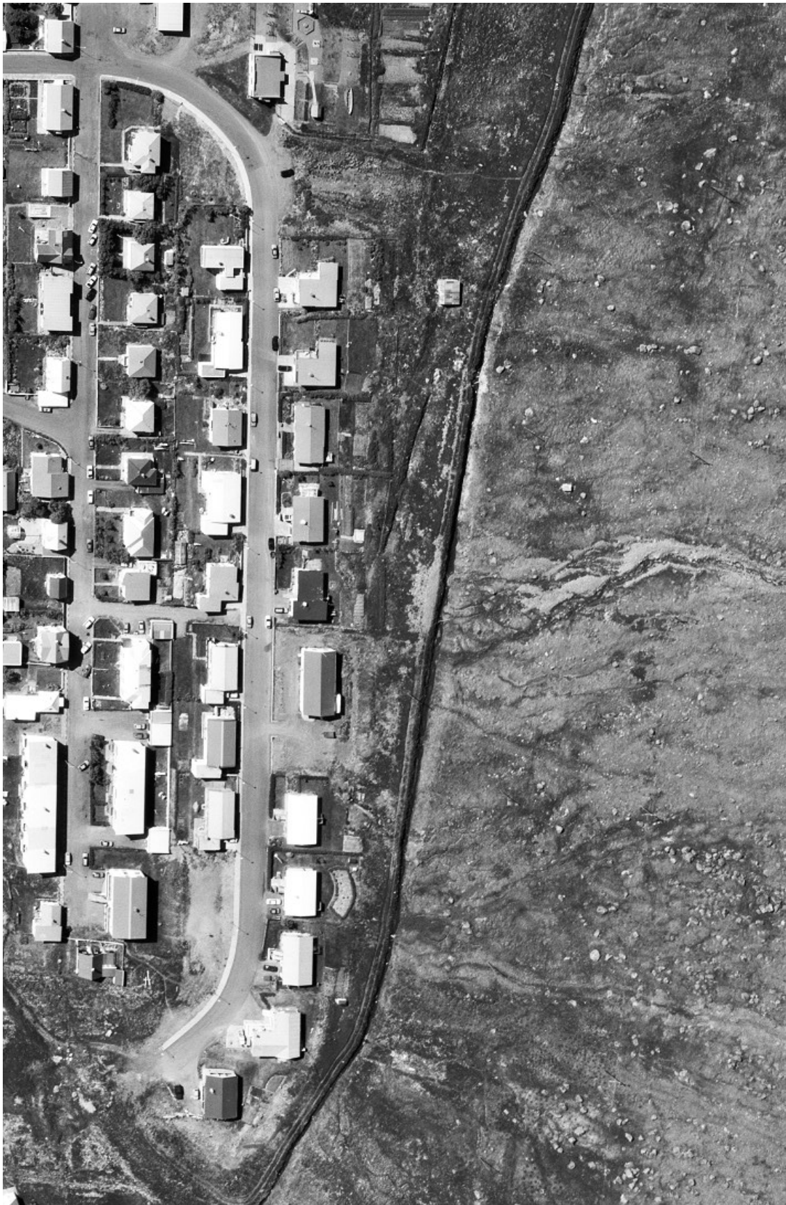
MYND V3: Svæði neðan aurvarnargarðs ofan Hjallavegar áður en framkvæmdir hófust
