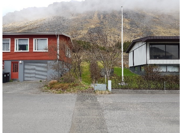
MYND 2: Búið að tengja vatn við rör og inn á lögn í götu.
