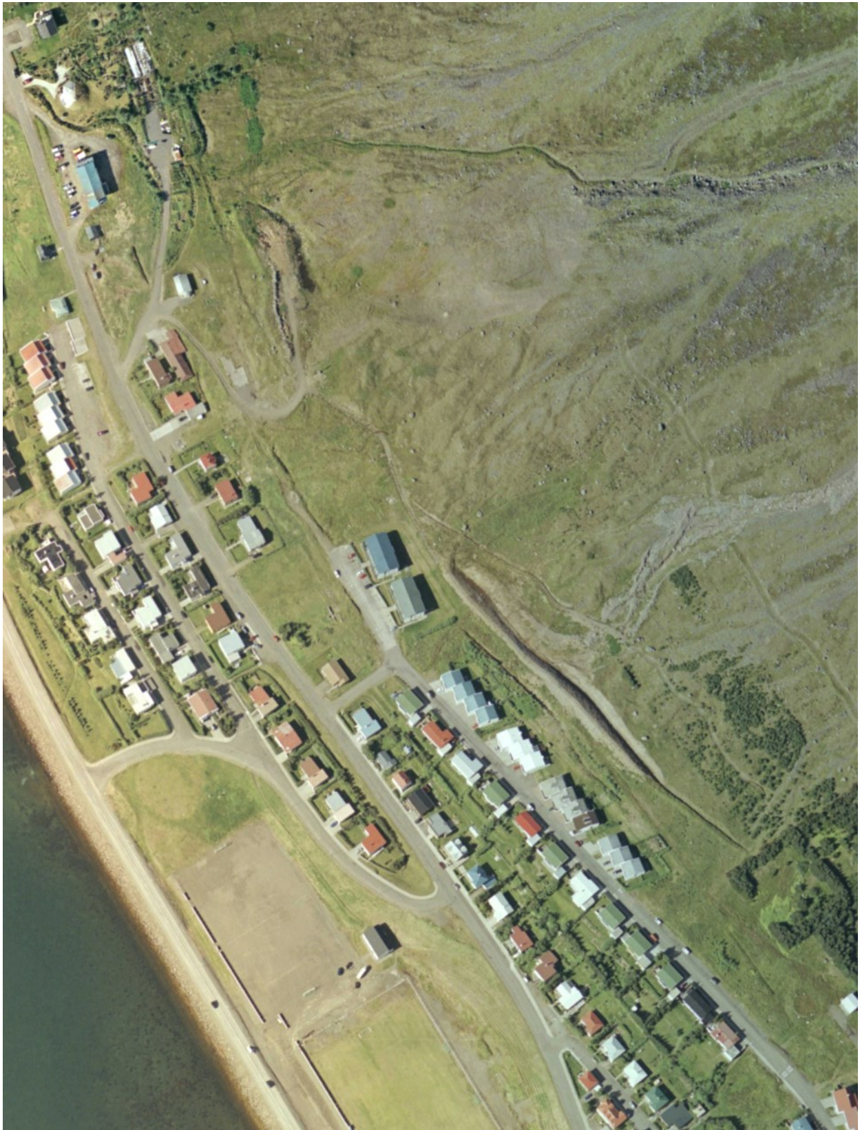
MYND V6: Svæði varnargarða ofan Urðarvegs og Seljalandsvegar áður en framkvæmdir hófust.
