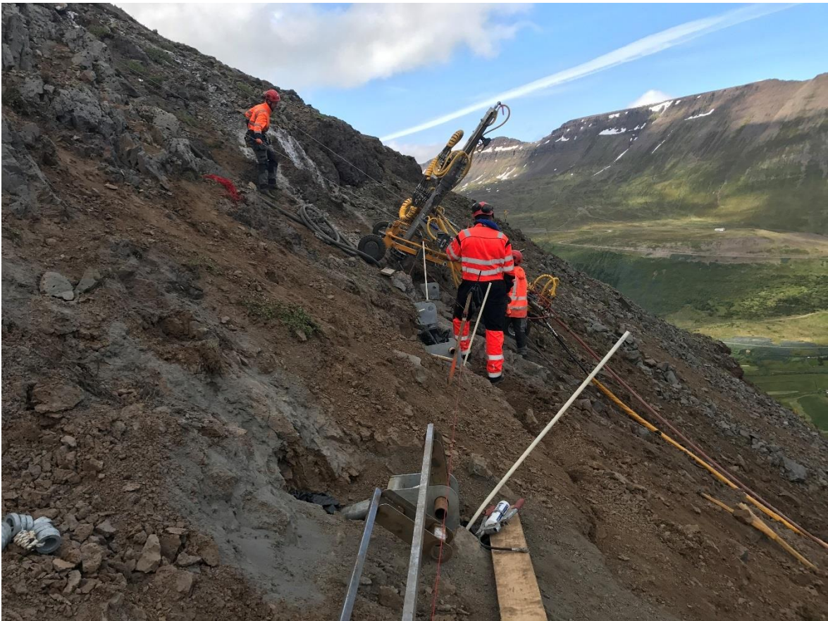
Unnið að borun.
