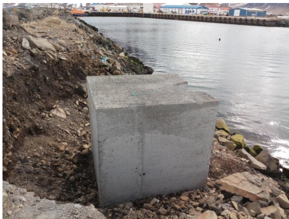
Nýr landstöpull kominn upp fyrir Bobby bryggju
