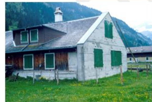
Mynd 5.10 Gluggar varðir fyrir beinu snjóflóðaálagi í Ölpunum. Myndir frá Stefan Margreth, SLF (júní 2020)
