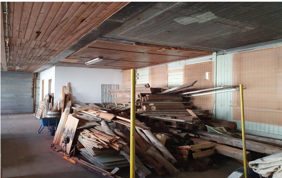
Fyrsta hæð, nokkrar tegundir loft og veggklæðninga, afstúkað herbergi í suð-austur horni
