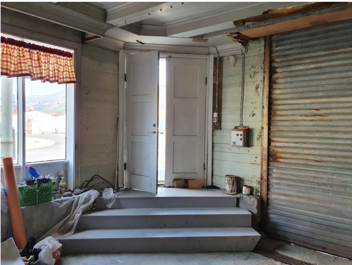
Fyrsta hæð, nýlegar tröppur úr timbri við suð-austur horn, steypur veggur brotinn undir tröppunum
