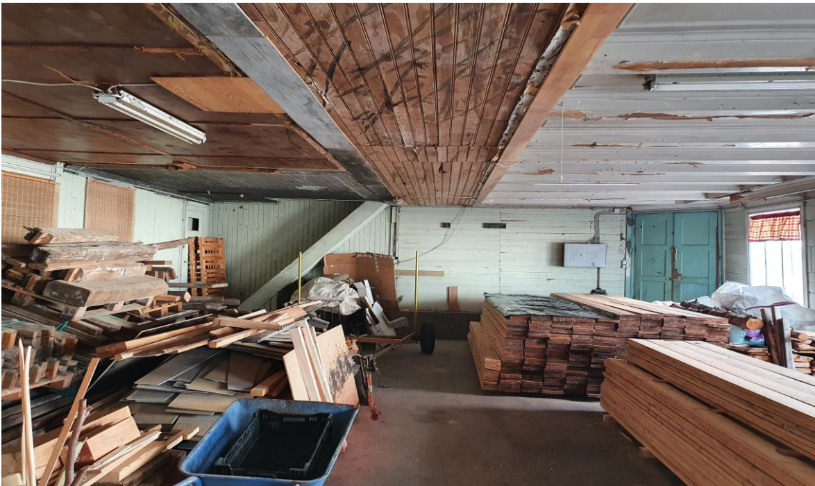
Fyrsta hæð, gólfið lækkað og steipt, súlur og langbiti í lofti fjarlægður
