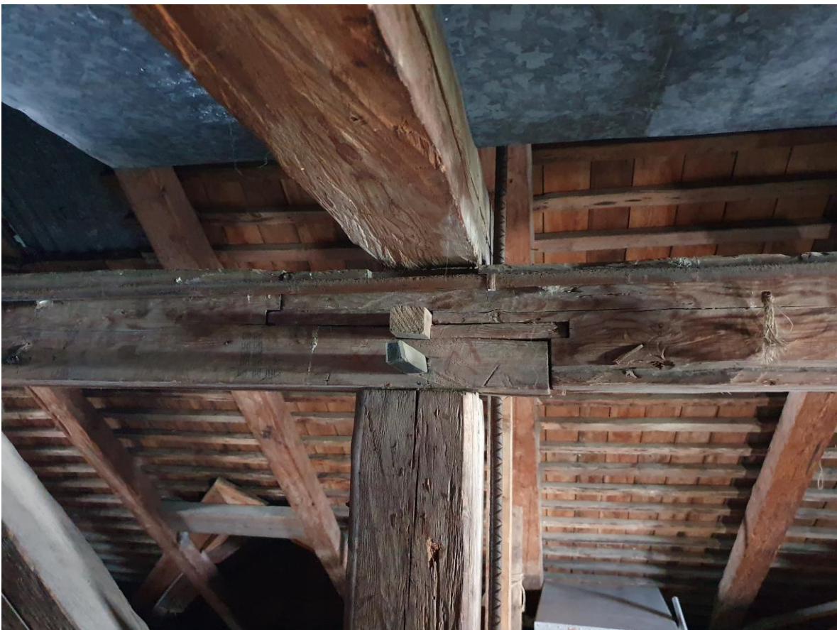
Rishæð, samsetning á langbita, þverbita og súlu. Einnig má sjá lektur og klæðningu á þaki
