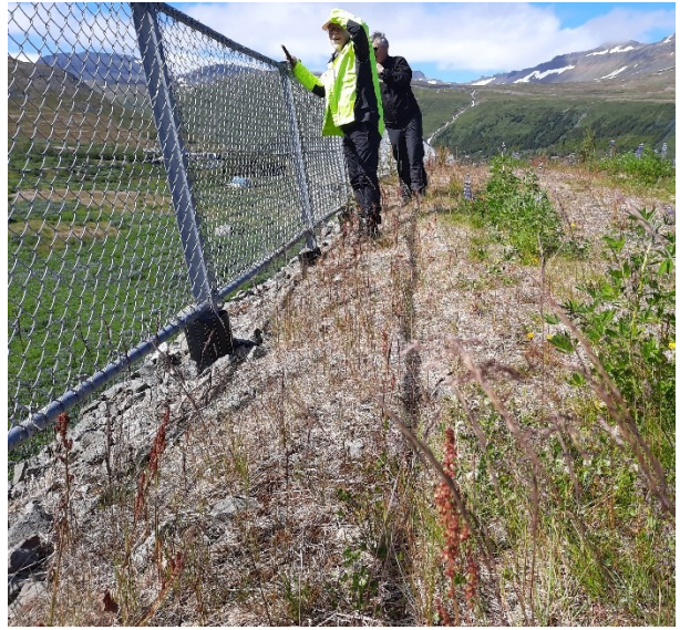
Halli á girðingunni sést vel. Einnig hæðarmunurinn á toppi garðs og frambrún.
