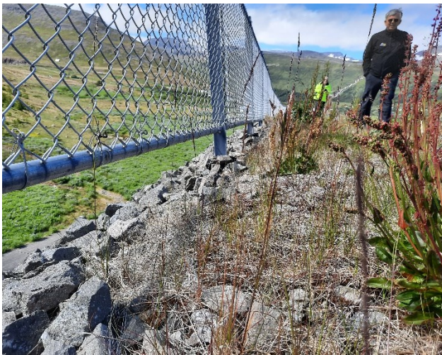
Of mikið bil milli garðtopps og girðingarnets greinilegt
