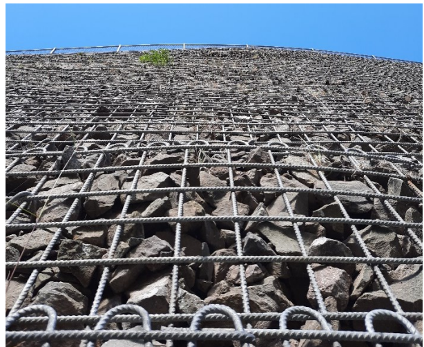
Mynd tekin upp garðinn. Efsti hlutinn er búinn að færast það langt út að það sést ekki í girðinguna.
