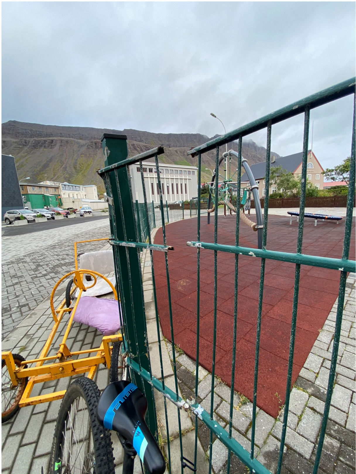
Girðinga er beygluð og brotinn á hinum ýmsu stöðum. Málning farin að flagna af. Hlið er beygluð og slitið.
